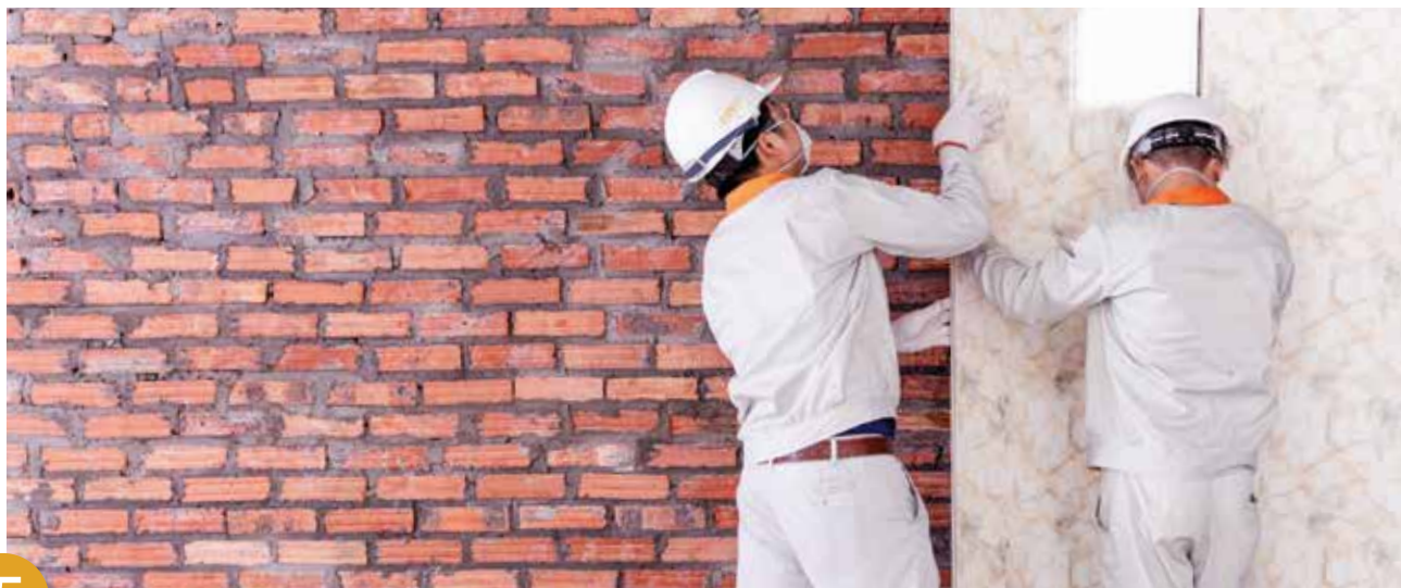
4 Lắp khóa hèm vào tấm đầu tiên, dùng vít nở hoặc súng bắn đinh cố định khóa hèm cùng tấm vào tường
