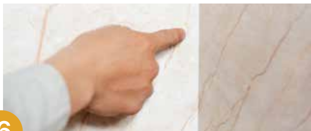
5 Ốp tấm tiếp theo khít vào tấm đầu tiên theo hèm khóa âm dương
